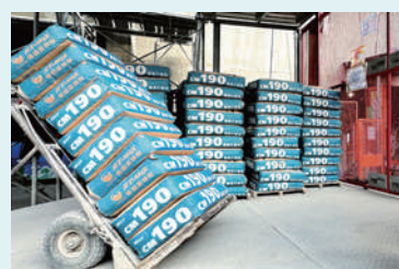
砂與原料比例完美調和 施工物料擺放整齊好清點
