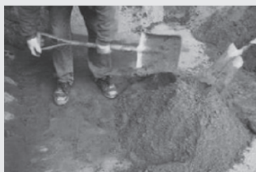
工人依據經驗和感覺將砂和水泥於地面加水拌和
