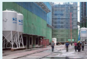
使用儲料桶管理砂漿材 工地乾淨整潔不泥濘
